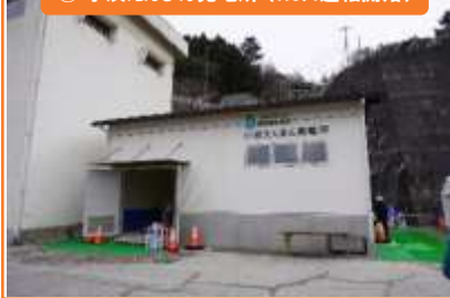
20 小洪えんまん発電所 (R3.4運転開始)
