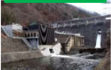
26 奈良井発電所
