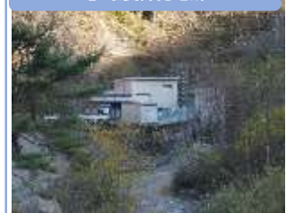
21 与田切川上流発電所地点 (取水口地点)
