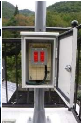
非常用コンセント
