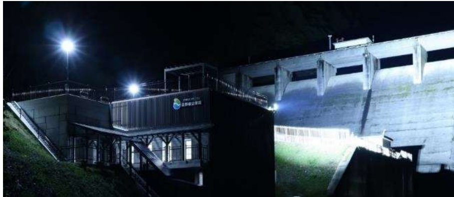
ライトアップ中の発電所
