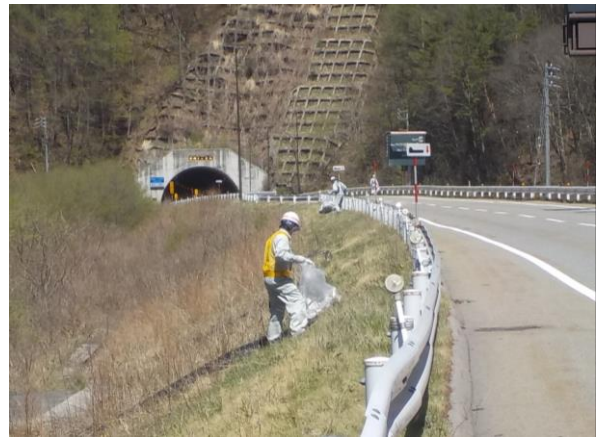
今年春の実施状況(羽瀨トンネル付近)
