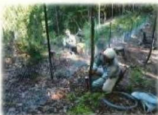
獣害防護柵設置
