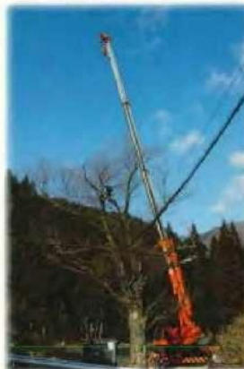
支障木伐採(特殊伐採)
