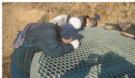
【地すべり防止施設点検状況】
