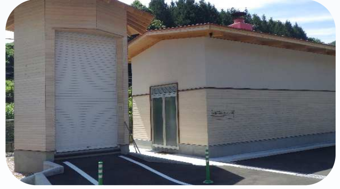
バイオマスボイラー棟
