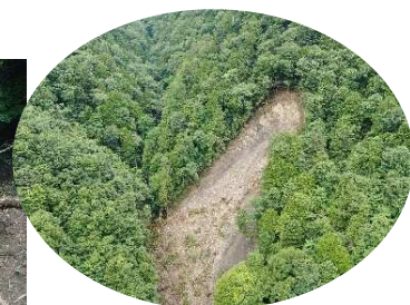
土石流の発生源の崩壊箇所 （ドローンで撮影）
