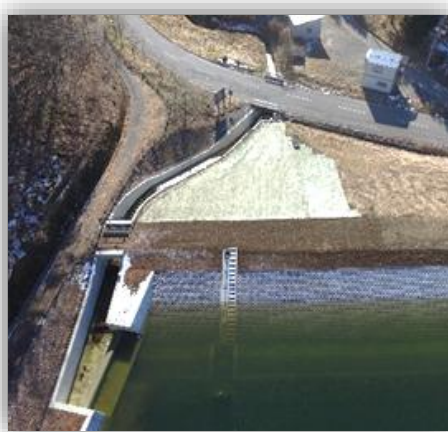
農業用ため池の防災工事 大平ため池(木祖村)
