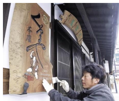
【 看板設置作業の様子 】
