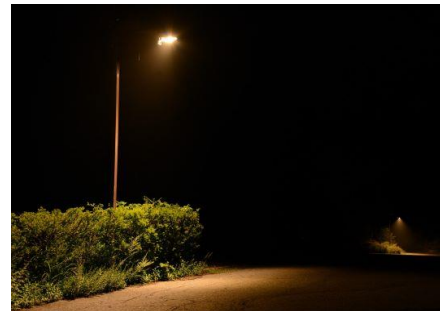
【LED灯具取付け後】
