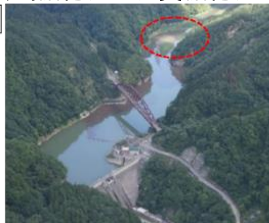
奥裾花ダムの堆砂状況
