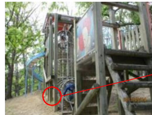
遊具の老朽化状況
