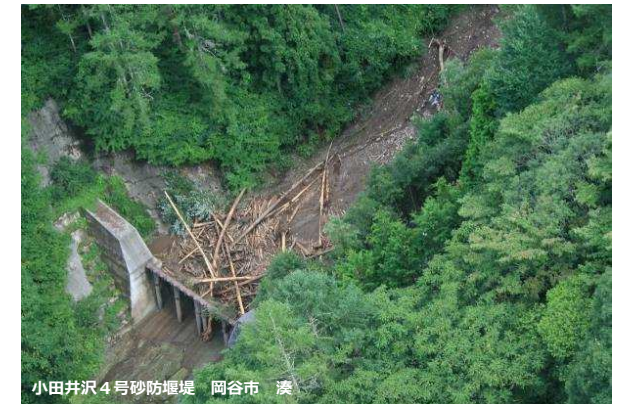
小田井沢4号砂防堰堤 岡谷市 湊
