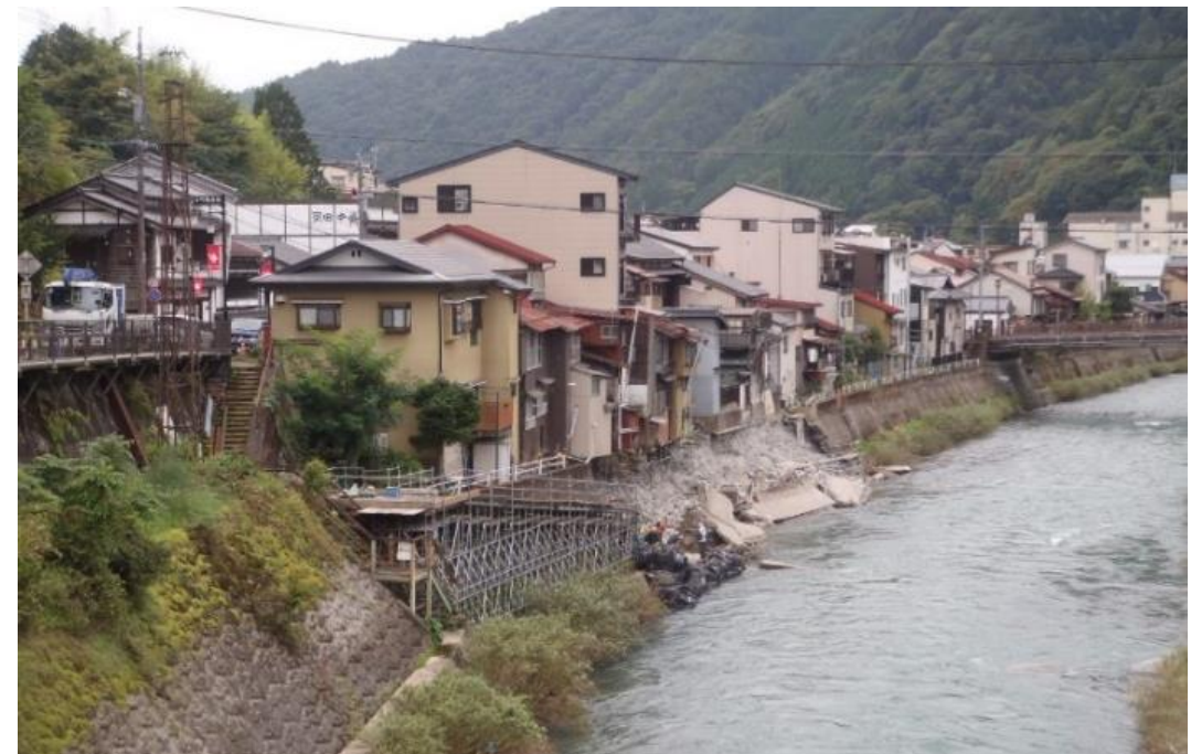
令和3年8月の大雨により 護岸基礎が崩れ 、 護岸に沿って並ぶ家屋12棟で倒壊の恐れ
