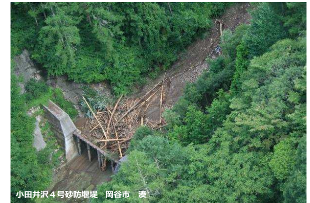
令和3年8月13日からの大雨により土石流が発生したが、砂防堰堤が整備されており、下流への被害を未然に防止
