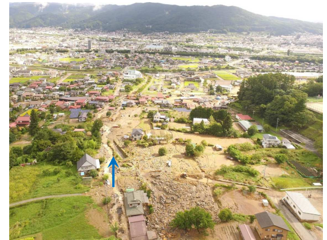
茅野市下馬沢川 令和3年9月の大雨により 土石流が発生 全壊3戸を含め 多くの家屋被害 が発生した
