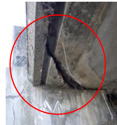
橋梁の桁のひび割れ、腐食
