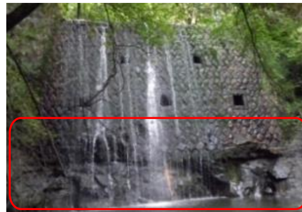
砂防堰堤の基礎洗掘
