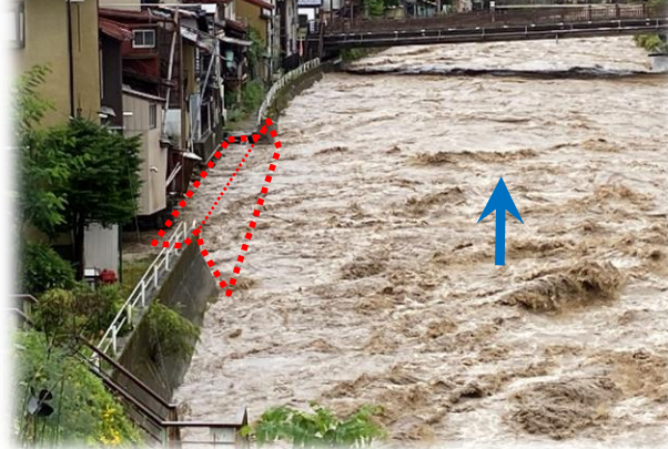
木曾川護岸被災
