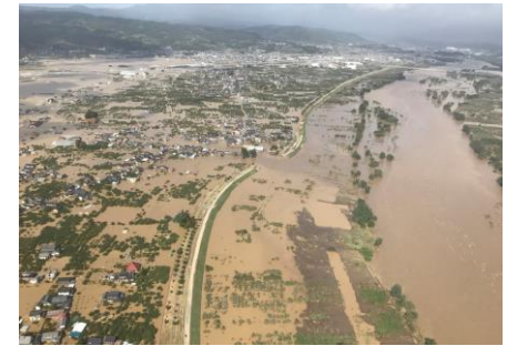
令和元年東日本台風による被害
