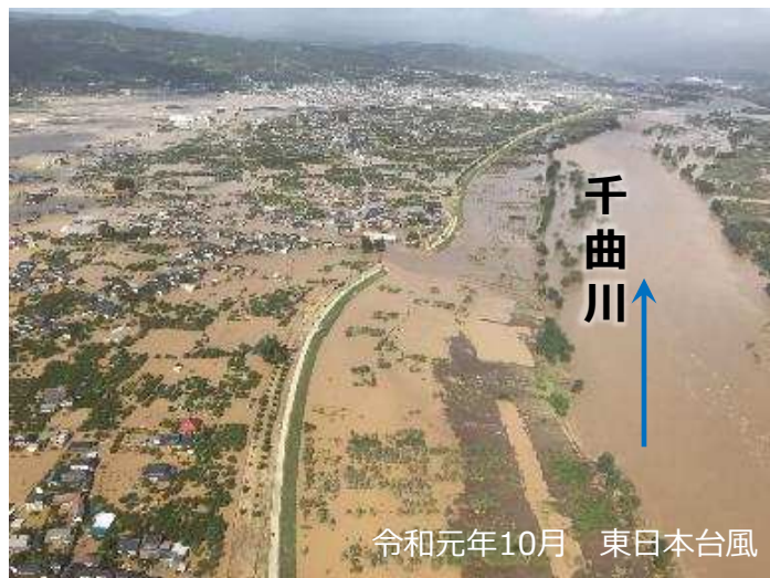
千曲川堤防決壊（長野市穂保） 令和元年10月 東日本台風
