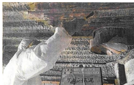
吹付けアスベスト除去作業
