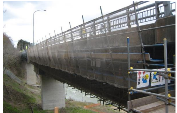
国道 117 号白鳥大橋修繕（栄村）
