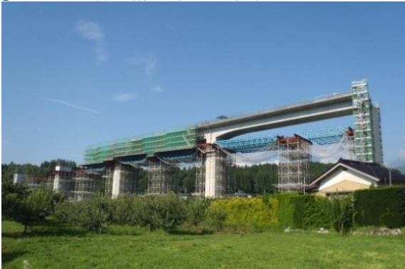
国道 153 号伊南バイパス（飯島町）
