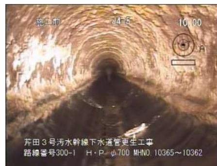
下水管の硫化水素による腐食状況
