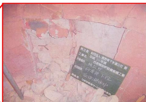
流動焼却炉の炉内剥落状況
