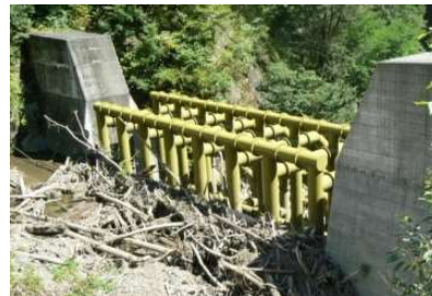
透過型堰堤の流木捕捉事例
