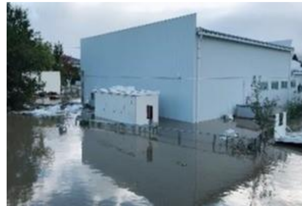
工場浸水（外観）
