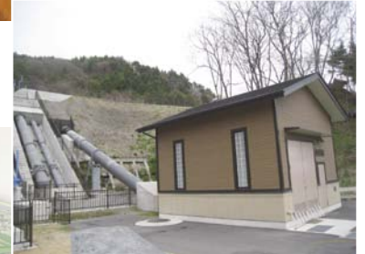
農業用水路の落差を利用した小水力発電
