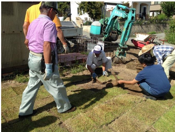
地域住民による広場の芝張り作業
