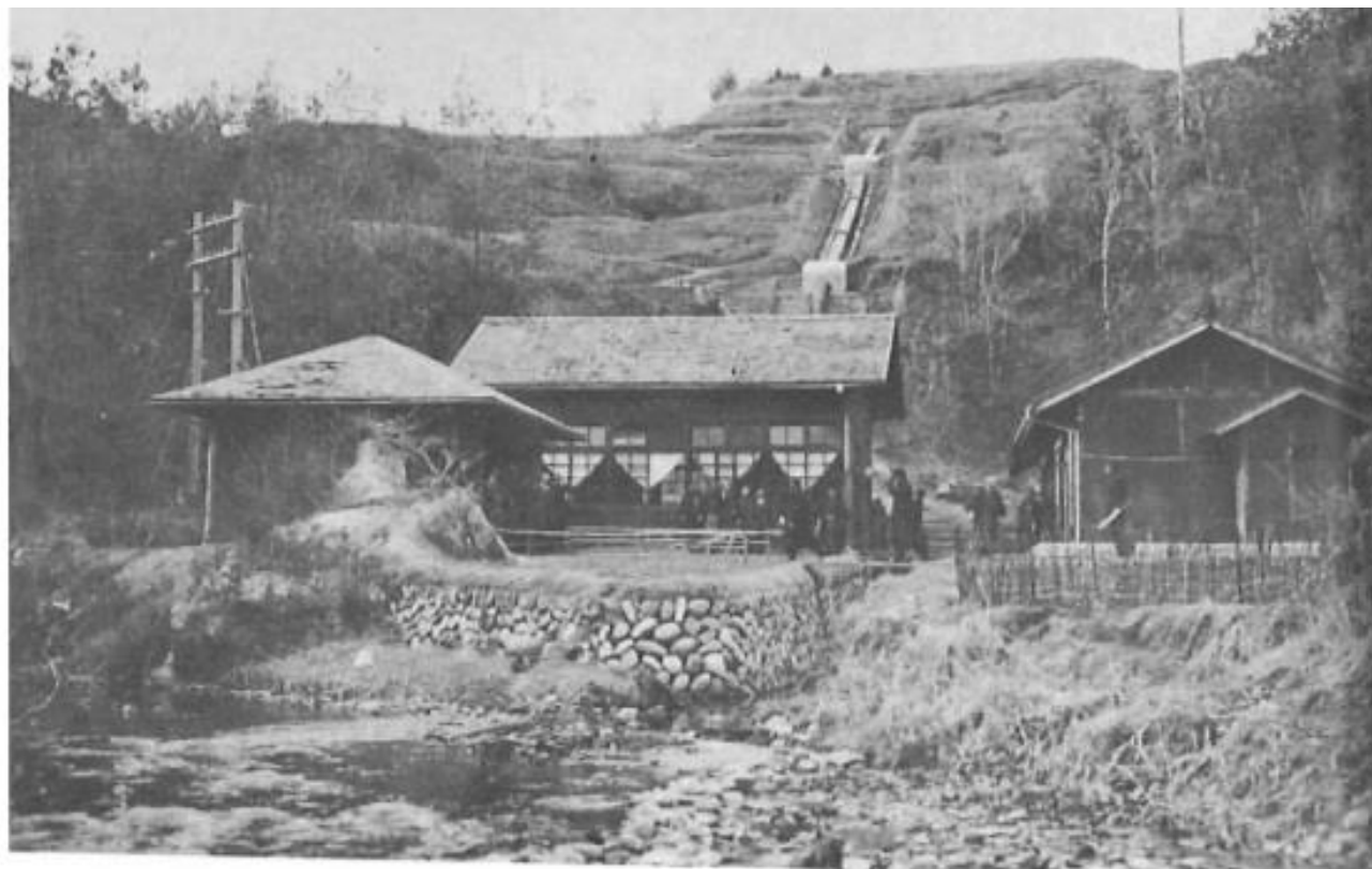
日本初の組合型小水力発電、竜丘電気利用組合の発電所(30kW) 大正3年～昭和10年代
