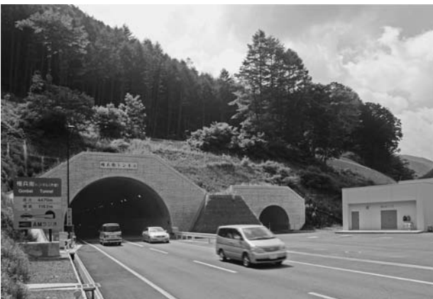
権兵衛トンネル（伊那木曾連絡道路）
