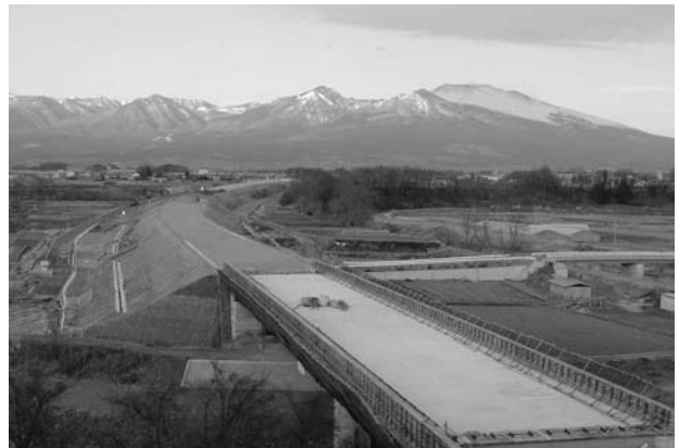
整備が進む中部横断自動車道
