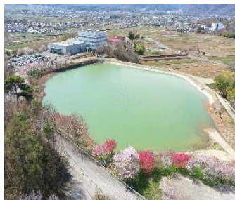
防災工事を実施した農業用ため池 (上田市浅間池地区)
