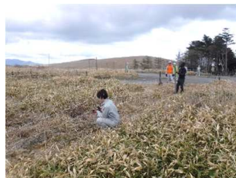
霧ヶ峰車山肩における 防鹿柵設置作業の様子
