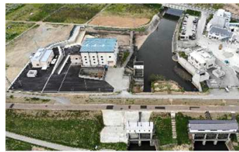
浅川排水機場
