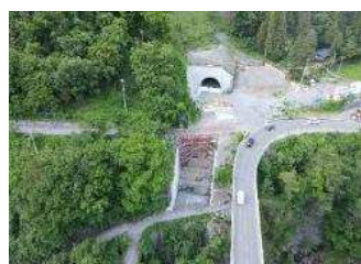
国道158号 (松本市 狸平)
