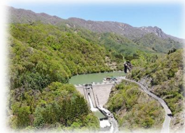
県の水力発電所(11か所)
