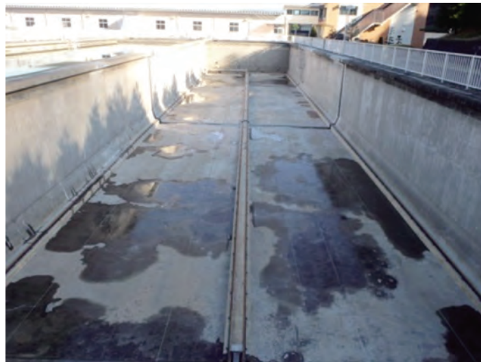
本山浄水場沈砂池耐震化工事（平成26年度耐震補強実施済）
