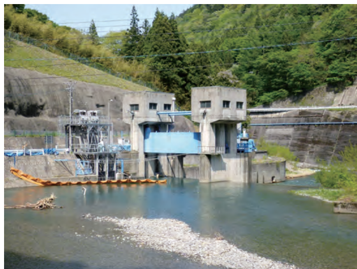
片平取水口（耐震補強工事実施予定）
