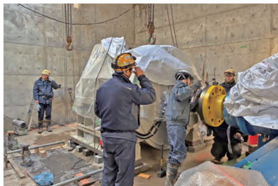
湯の瀬いとおしき発電所の発電機据付 (長野市)
