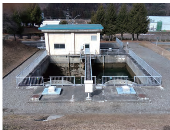
耐震化工事を予定する排水池（本山浄水場）
