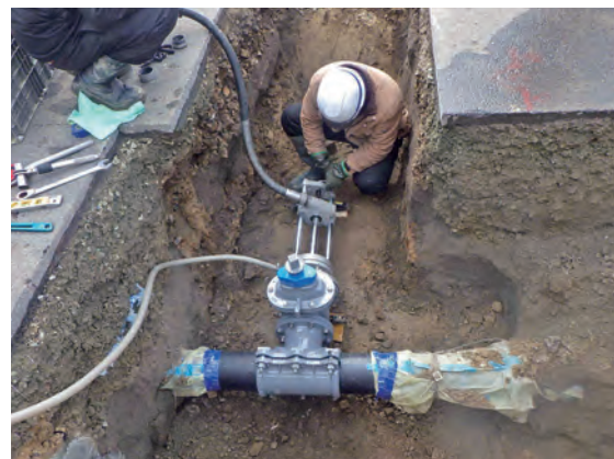
老朽管工事(長野市今里地区)
