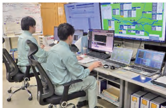
発電所の監視制御の様子（中央制御所）
