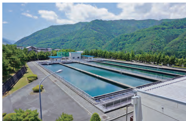
本山浄水場（塩尻市）
