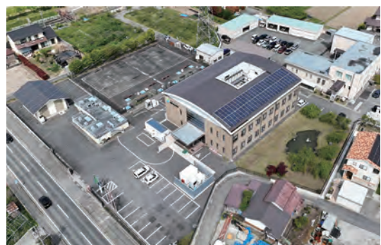
四ツ屋浄水場(長野市)
