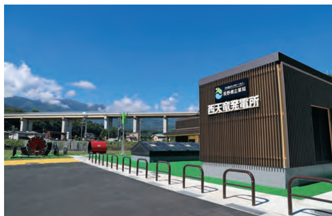
西天竜発電所（伊那市）
