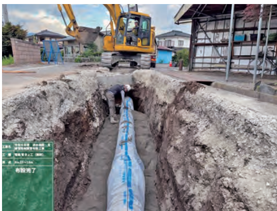
送水管の布設工事（塩尻市宗賀地区）
