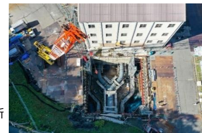
改修中の春近発電所
