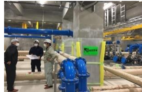
山ノ内町にて浄水場建設現場の視察 令和2～4年度 新東部浄水場浄水棟建築建設工事
