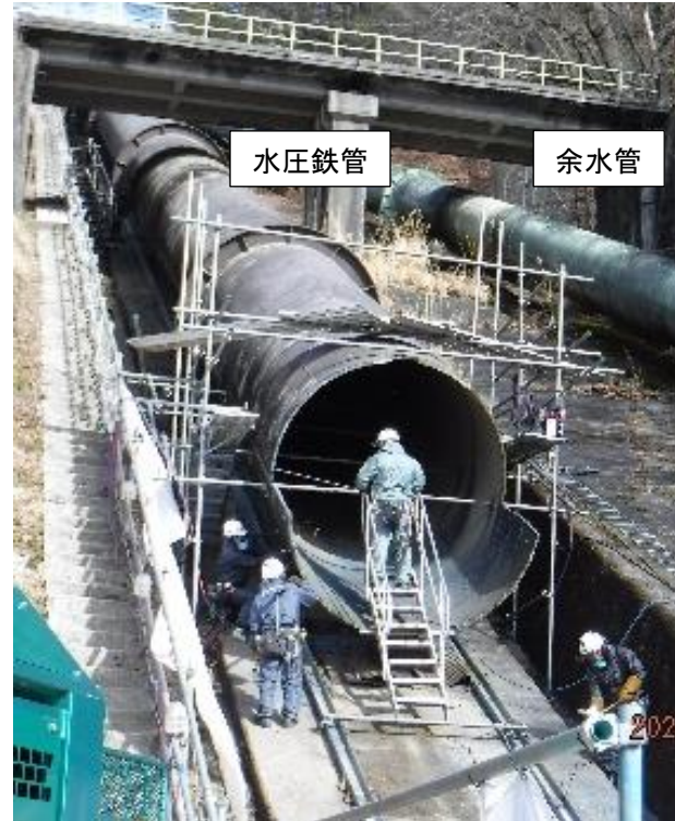
水圧管路の状況
