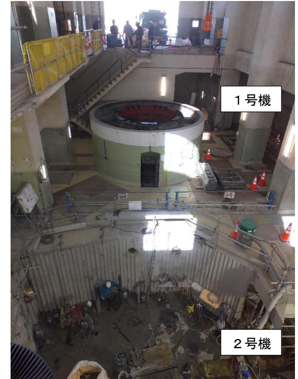
発電所の状況
