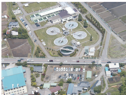
諏訪形浄水場
