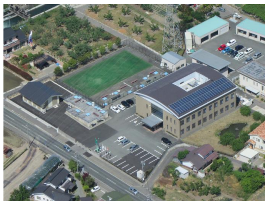
四ツ屋浄水場
