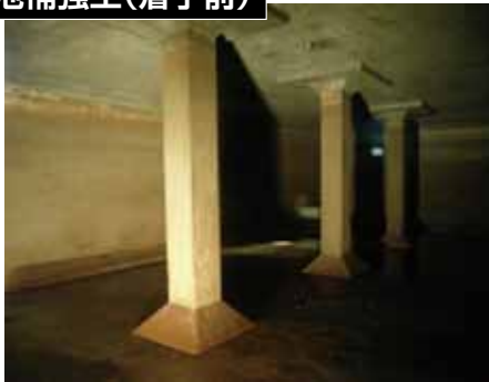
配水池補強工(着手前)
