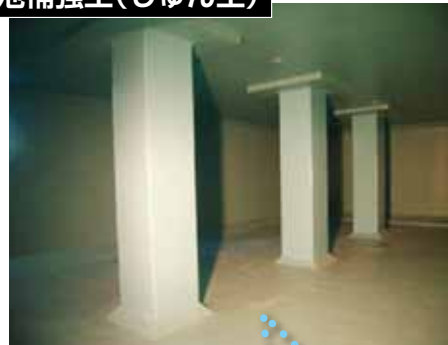
配水池補強工(しゅん工)
