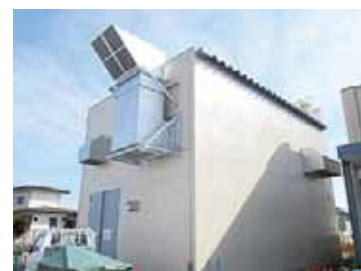
発電装置建屋
