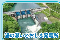
湯の瀬いとしき発電所
