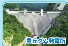
豊丘ダム発電所
