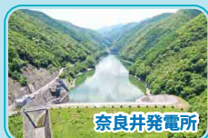
奈良井発電所
