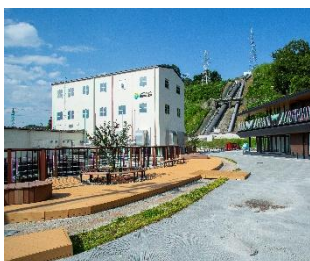
憩いの場として敷地開放される 春近発電所
