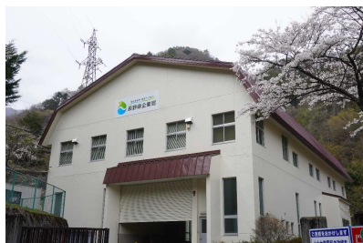
与田切発電所
