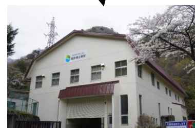
与田切発電所
