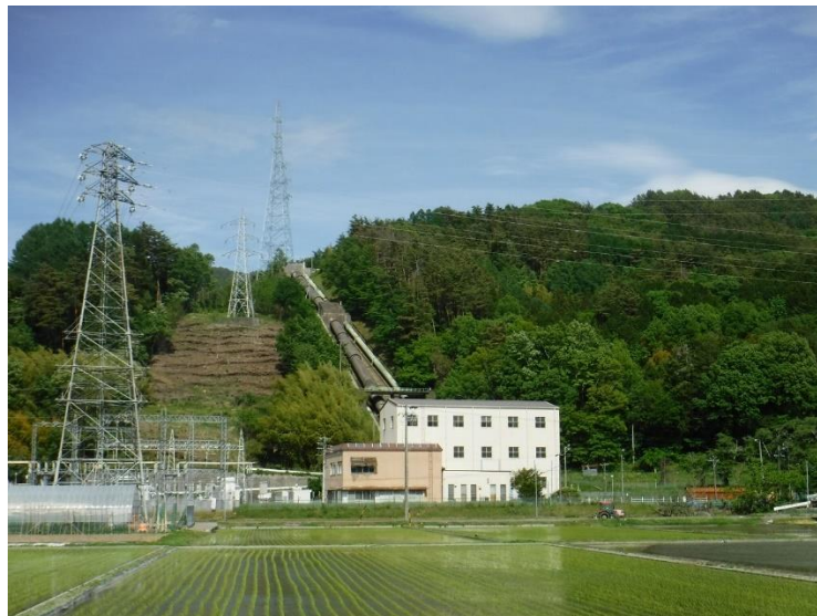
長野県企業局 春近発電所(伊那市)
