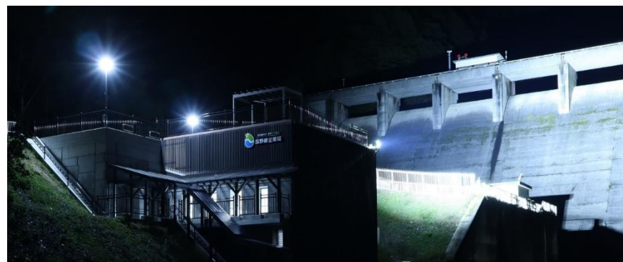
ライトアップ中の発電所(左)
