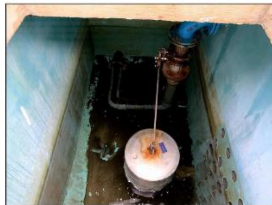
位置： 平第1配水池 撮影日： 令和元年11月28日 着水井内
