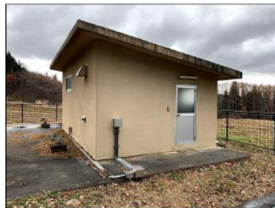
位置： 平第1配水池 撮影日： 令和元年11月28日 減菌・計装室
