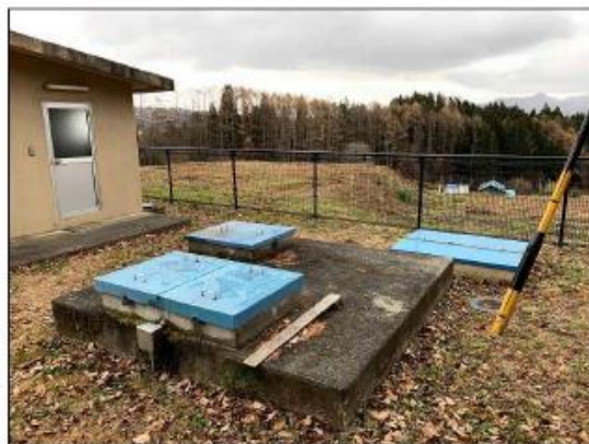
位置： 平第1配水池 撮影日： 令和元年11月28日 着水井
