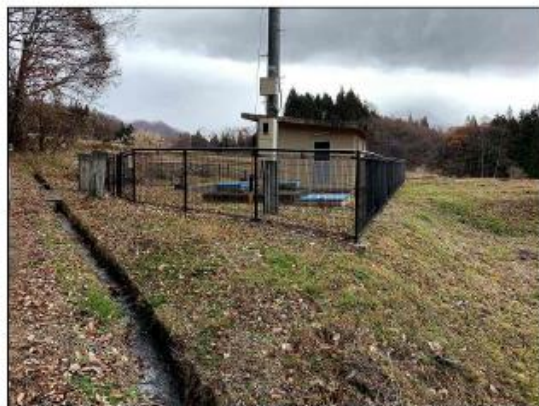
位置： 平第1配水池 撮影日： 令和元年11月28日 全景
