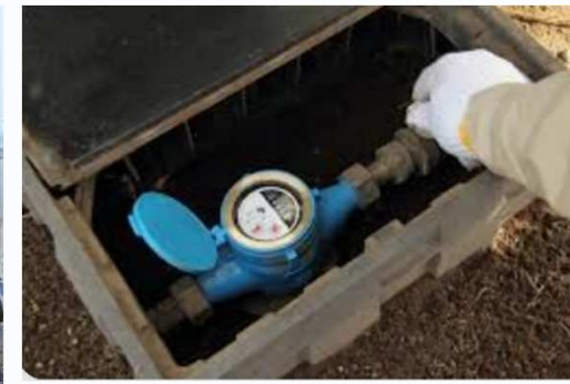
水道メーター交換
