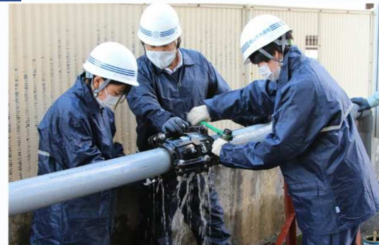
漏水修繕研修
