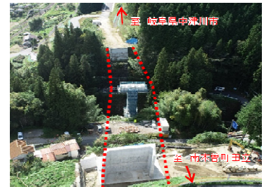
主要地方道 中津川田立線
