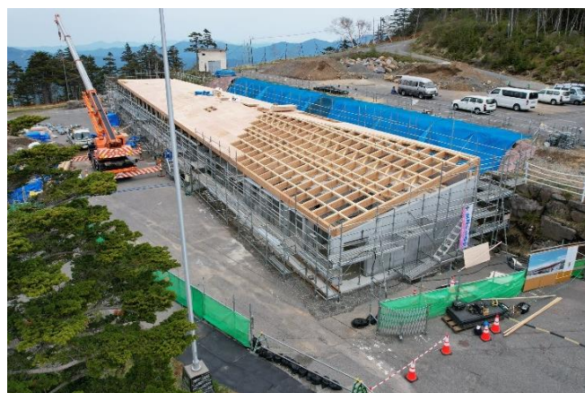
施工中の様子（R4年6月1日）
