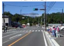
通学路等の交通安全対策推進事業 (主)駒ヶ根長谷線 駒ヶ根市 下平
