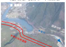
災害時における道路の迂回機能強化事業 木曾川右岸道路
