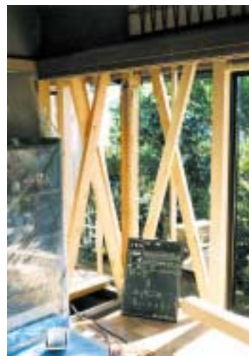
耐震補強工事
