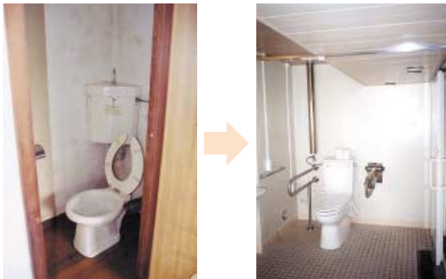
身体障害者向け改修を行った県営住宅笹部弥生団地（松本市）
