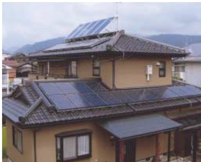
太陽光発電システム設置住宅
