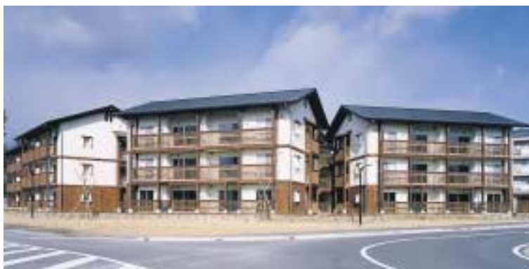
木造での建替えを行った県営住宅上新井団地（松川町）
