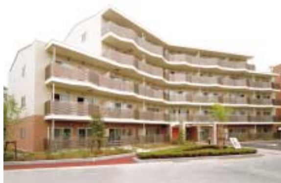
長野県住宅供給公社による高齢者向け賃貸住宅シニア犀北（長野市）
