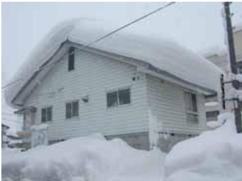
低温続きのため雪が張り付いて落ちずに厚く堆雪してしまった落雪式の屋根
