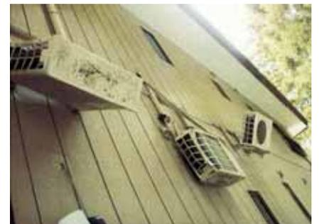
2階まで降り積もった雪の雪解けとともに破壊されたエアコン室外機
