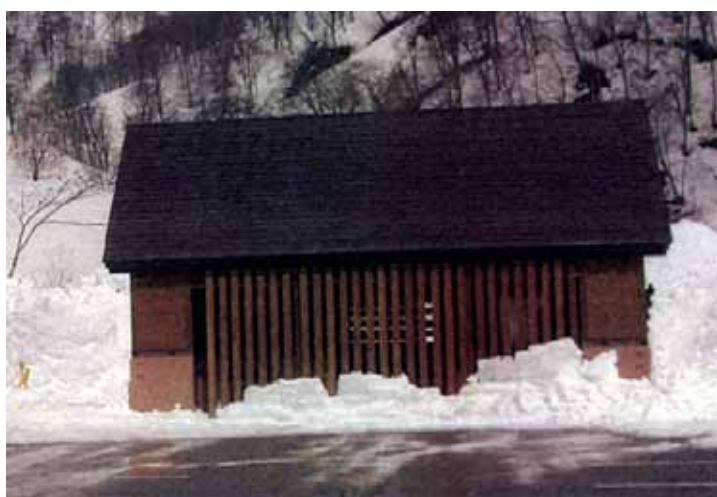
雪囲いのように雪に接する部分は、 横よりも縦の方が融雪等に伴う被害 を受けにくい
