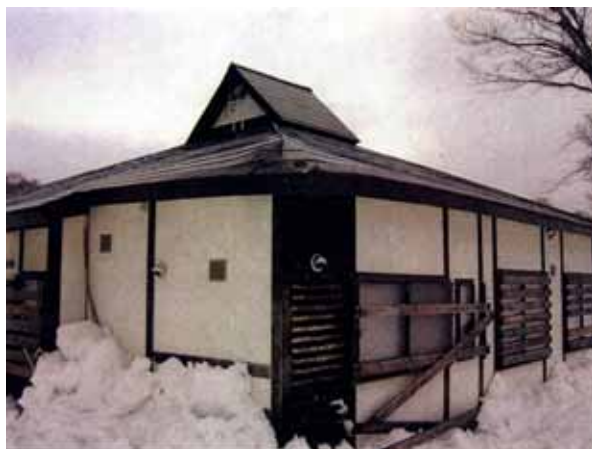
積雪から窓等を守るための雪囲い
