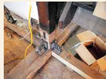
柱脚部の金物による耐震補強工事
